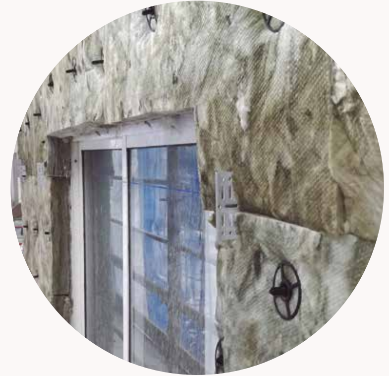
Rehabilitación integral en Donostia, Kursaal Rehabilitaciones.
