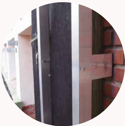
Rehabilitación con fachada ventilada en Miranda de Ebro, Ayuntamiento de Miranda de Ebro
