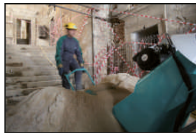
Esgráper/mulilla "opcional", de tracción hidráulica, para facilitar la carga de los materiales sobre la tolva/skip, reduciéndose el esfuerzo personal, y agilizándose el ciclo de trabajo.
