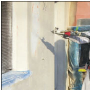
Gracias a su "INVERTER" podemos regular el cuadal de los materiales, para de esta forma poder enfoscar / proyectar materiales que requieren la aplicación de una capa fina
