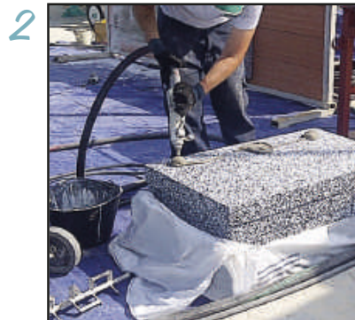
Aplicación del cordón sobre el panel "EPS" termoaislante
