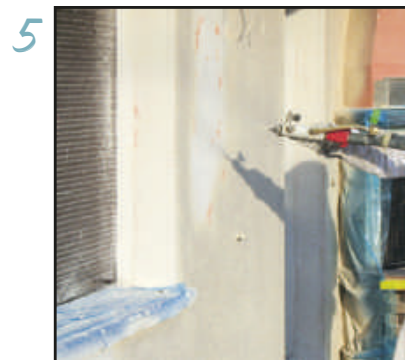
Aplicación proyección del acrílico final
