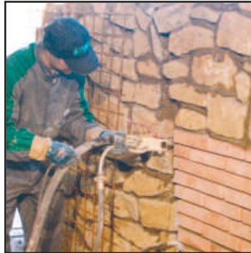
Realizar relleno de juntas
