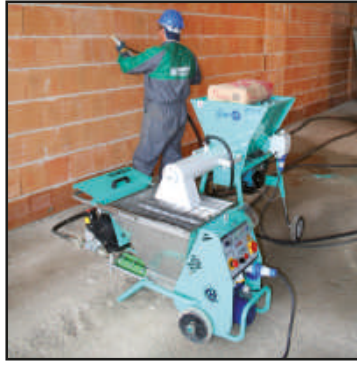
Alimentada por un mezclador continuo, para múltiples tipos de materiales premezclados (Mezclador IMER modelo SPIN-15 A)
