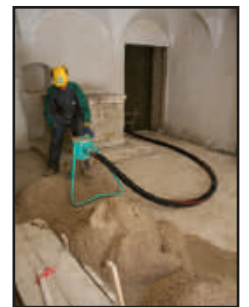
Caballote/trípode para recepción y reparto demorteros y áridos en planta. Se suministra siempre de serie.
