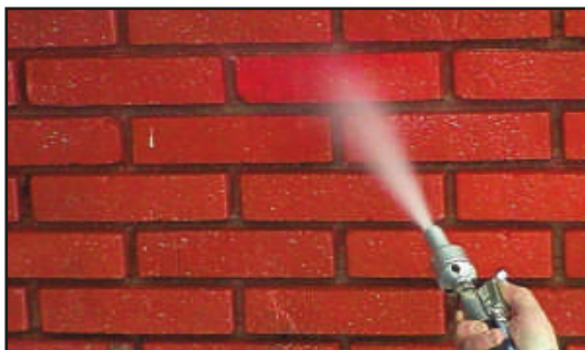
Paredes de ladrillo, de hormigón...
