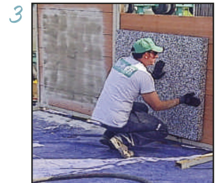
Colocación del panel "EPS" termoaislante
