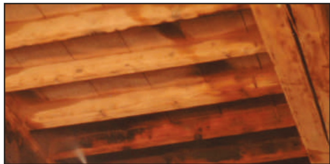
Techos y paredes de madera
