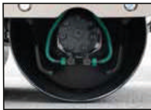
Protección de los latiguillos hidráulicos contra daños producidos por piedras.
