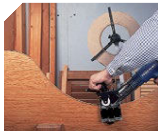
Aplacado de piezas circulares o con formas.
