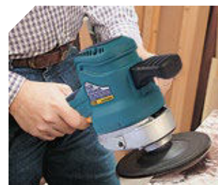
Trabajos de marmolistería.
