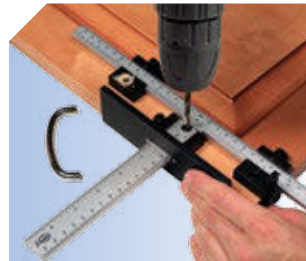
Taladrado para tiradores de puertas.
