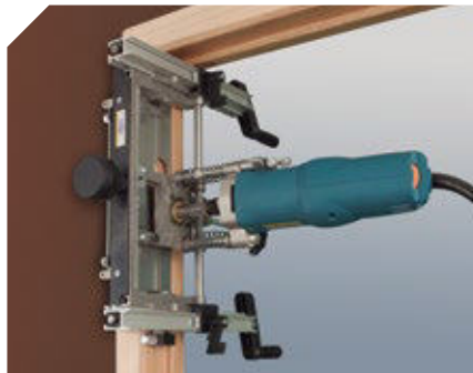
Realización del encaje superior en el marco.
