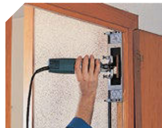
Colocación en el marco (Mod. A093)
