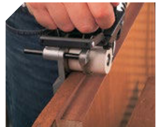
Aplacado de la cara superior del solape.
