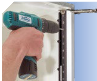
Taladrado para la colocación de estantes.
