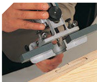
Colocación de pernios con el cabezal ZB93.
