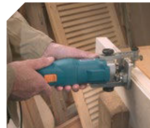
Realización de molduras.
