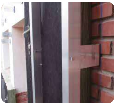
Rehabilitación con fachada ventilada en Miranda de Ebro, Ayuntamiento de Miranda de Ebro
