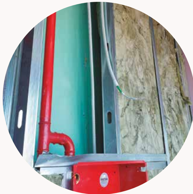
Torre Caleido, Madrid
